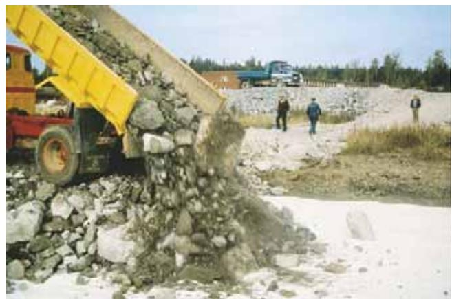
2 Dieses Beschütten eines Trenn- und Filtervliesstoffes dokumentiert die Wichtigkeit einer beanspruchungsgerechten Festlegung der Geotextilrobustheitsklasse
